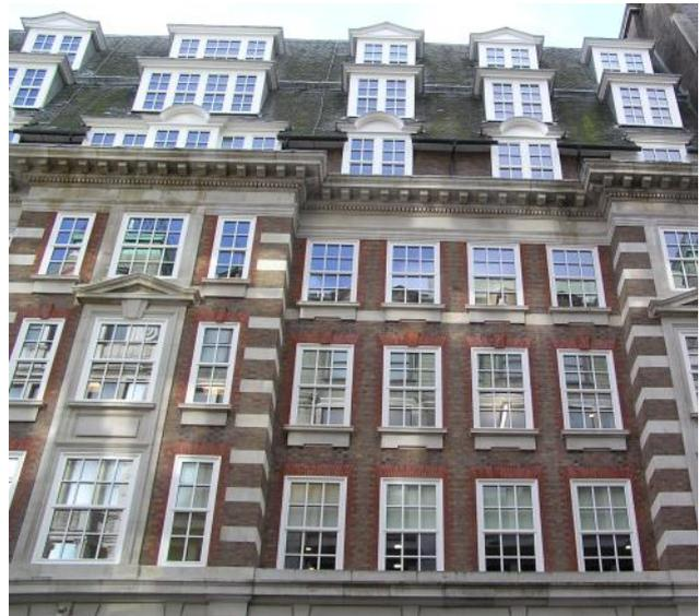
Projektbeispiel: Druckwellenhemmendes Aluminiumfenster mit Holzbeplankung, originalgetreuer Nachbau der Vorlage.
