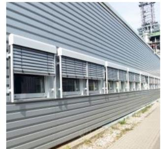
Druckwellenhemmende Fenster mit Jalousiesystem, geprüft mit einem Druck von 1,12bar bei einer Druckdauer von 2 Sek. Pressure waves resistant windows with blinds, was tested with a pressure of 1,12bar, duration of the pressure 2.sec.
