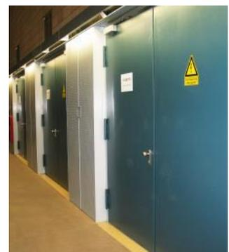
2 fig. Stahltür für Traforaum, geprüft mit einem Druck von 0,93bar u. einer Druckdauer von 4,5 Sek., Feuerwiderstand EI 90 (T90), BS 120 Min. Double steel door for a transformer room, was tested with a pressure of 0,93bar, duration of the pressure 4.5s, fire resistance EI90 (T90), BS 120 Min.
