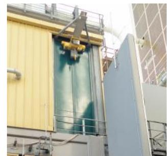
2 fig. 6m hohes Stahltor, mit integriertem Kran für ein Lager. Double sash steel gate, 6m high, with integrated crane for a warehouse.
