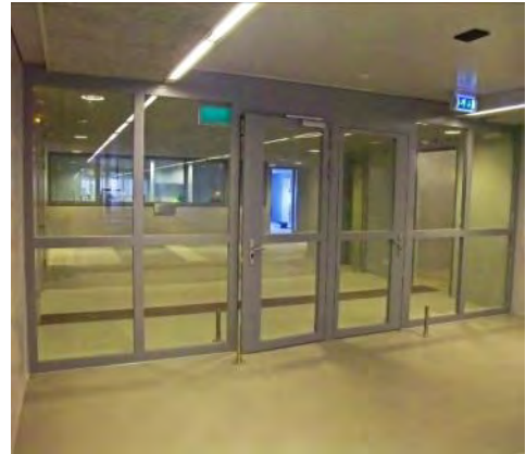
Flurtür SECUFIRE® voll verglaste Stahlrohrrahmentür. Sicherheitsoptionen: RC4, EI45, S200, FB4-NS.
