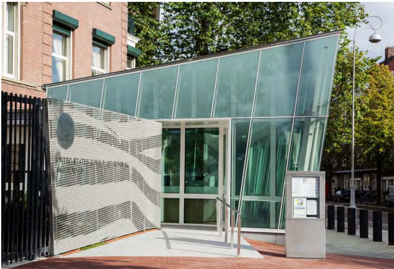
Wachhaus für die Eingangskontrolle zu einer US-amerikanischen Botschaft. Foto: Mit freundlicher Unterstützung der Wayss & Freytag Ingenieurbau AG.
