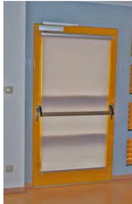
Verglaste Fluchtwegtür mit Antipanikbeschlag, Einbruchschutz bis RC4.
