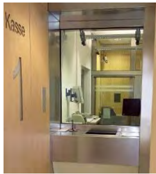
Komplettelement Schalterfenster: Festfeld, Schiebemulde, Sprechanlage.
