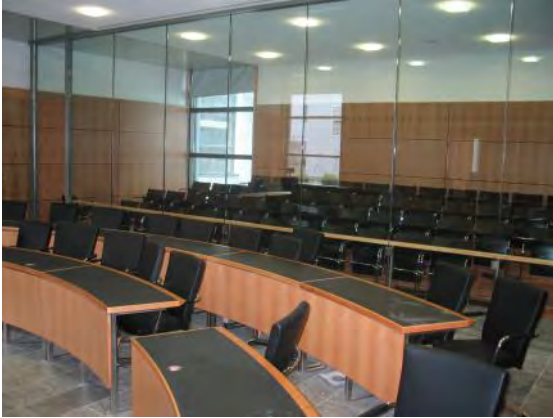
Durchschusshemmende Sicherheitstrennwand in einem Gerichtssaal.
