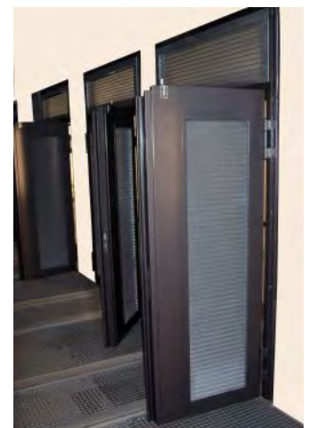
Einbau der Lamellen in eine einbruchhemmende Stahltür in RC4 mit Antipanikbeschlag.
