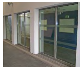
Trennwand in einer KFZ-Schleuse einer JVA.
