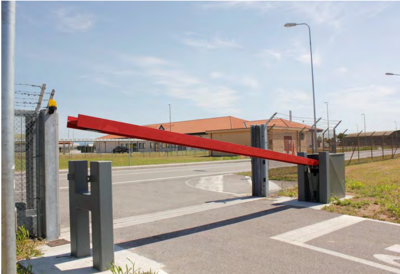
Sicherheitsschranke K4, Durchfahrtschutz zu einer militärischen Liegenschaft.
