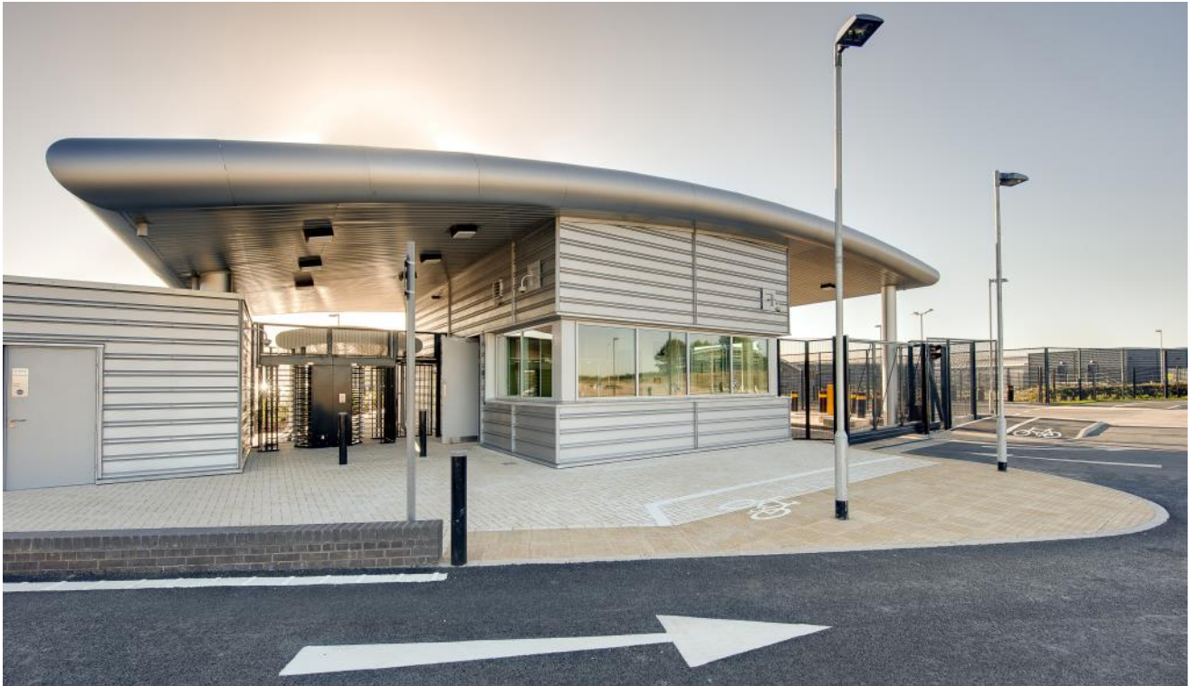
Eingangspforte zu einem Rechenzentrum.
