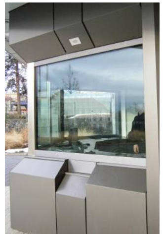
Außenlautsprecher in Decke und Mikrofon im Rahmen integriert, Aluminiumverkleidung ist sandgestrahlt.
