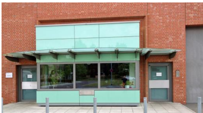
Eingangspforte zu einer Justizvollzugsanstalt. Wachkabine mit 2 separaten Eingänge für Besucher und Personal sowie einer LKW-Zufahrt.
