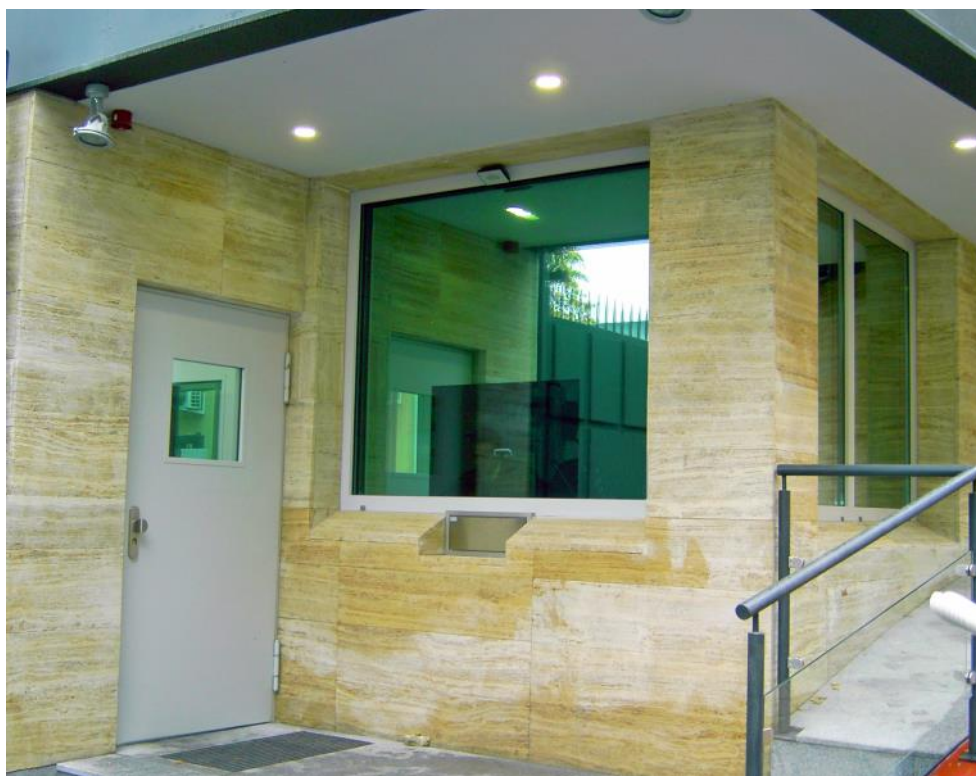
Eingangsbereich einer Deutschen Botschaft. Schalterfenster mit flächenbündiger Schiebemulde, verglaster Sicherheitsstahltür.
