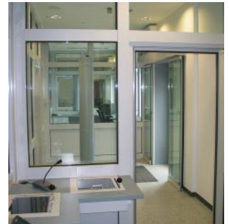
Pförtnerkabine integriert in Türschleuse.
