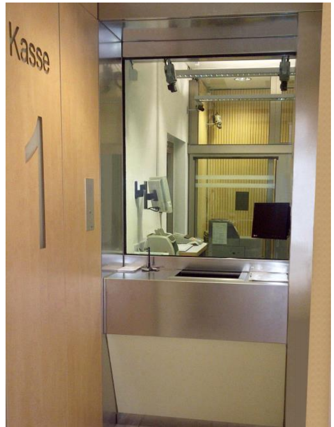
Außenlautsprecher in Decke und Mikrofon im Rahmen integriert, Aluminiumverkleidung ist sandgestrahlt.
