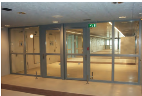
Designbeispiel: Flurabschlussstür in einem Sicherheitsbereich eines internationalen Flughafens. 2 Türen jeweils kombiniert mit Seitenteilen schützen zuverlässig gegen Ausbruch- und Befreiungsversuche.
